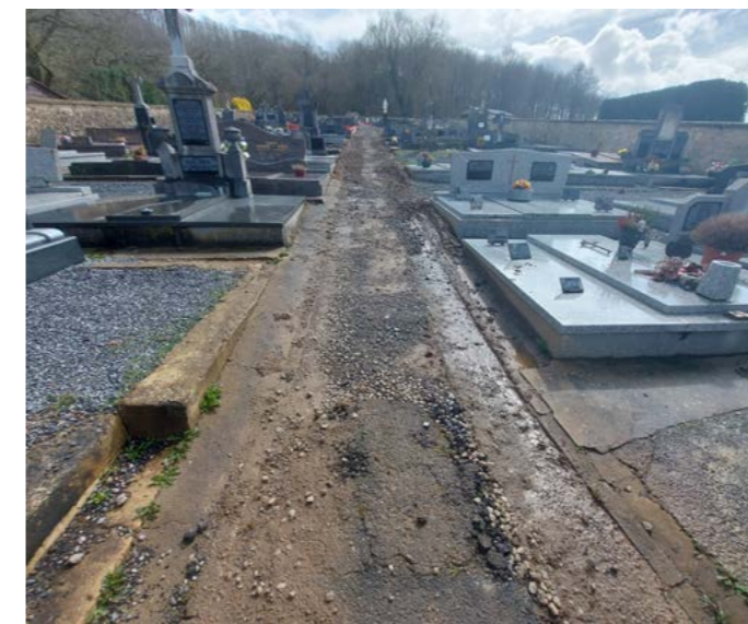
Allée du cimetière avant travaux
